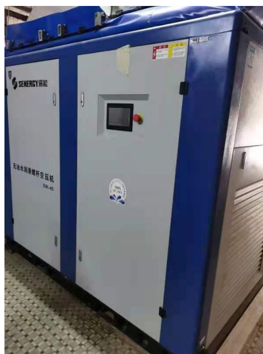
1 台 45kW 永磁電機及變頻功能的節能螺桿空氣壓縮機
